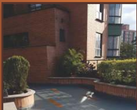
Aplicación de tintes para concreto
