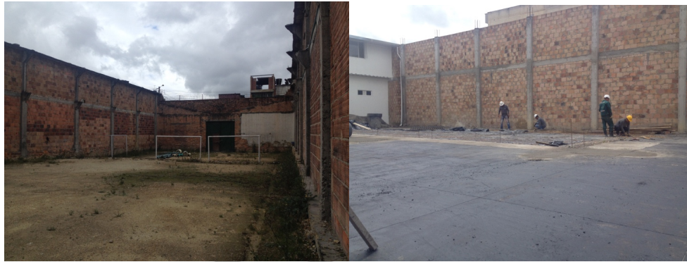
CONSTRUCCION CANCHAS SINTETICAS FUNDACION MARASUEÑOS BOGOTA
