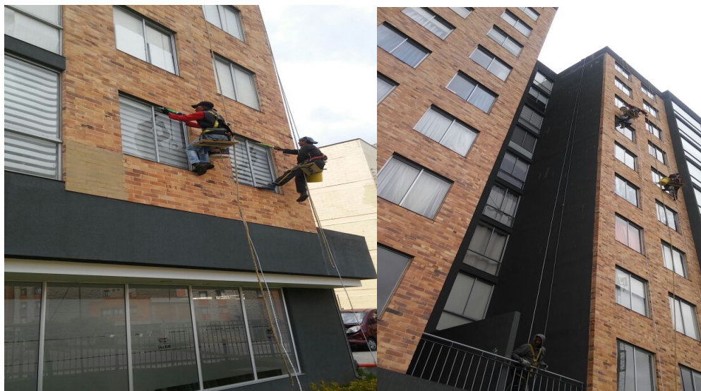
TRABAJOS DE MANTENIMIENTO / RESANES / PINTURA IMPERMEABILIZACION DE FACHADAS EDIFICIO ALAMEDA DE TORCA - BOGOTA
