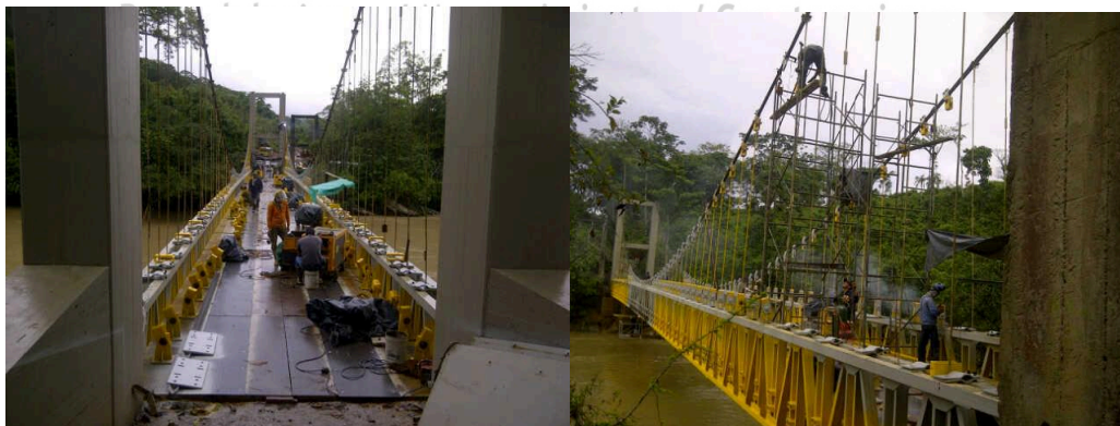
INTERVENTORIA -REPOTENCIACION DEL PUENTE AMARILLO METALICO EN SAN JUAN DE ARAMA DEPARTAMENTO DEL META
