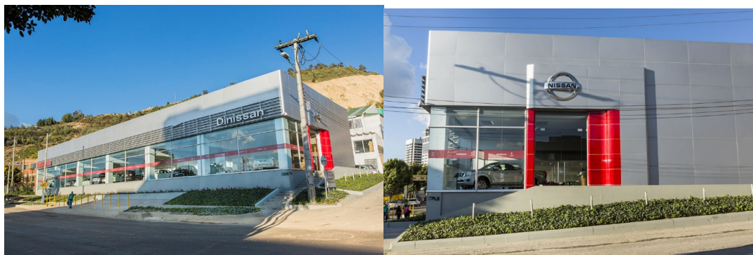
INSTALACION FACHADA EN ALUCOBOND NISSAN CALLE 153
