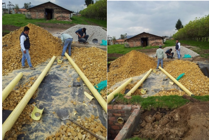
INSTALACION RED GENERAL AGUAS NEGRAS DEFENSA CIVIL FUNZA CUNDINAMARCA
