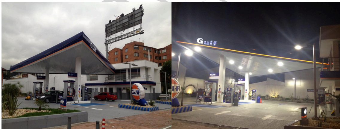
INSTALACION CENEFA EN ALUCOBOND CANOPY ESTACION DE SERVICIO GULF BOYACA CON 116
