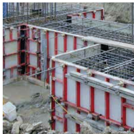
Cimentaciones para línea del metro, Viena, Austria.
