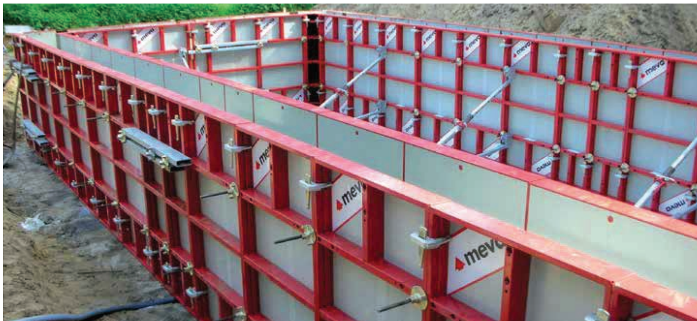
Muros para piscina, Herenhals, Bélgica.
