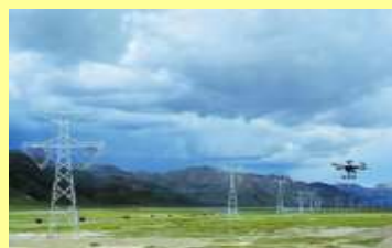
Monitoreo de Líneas Eléctricas
