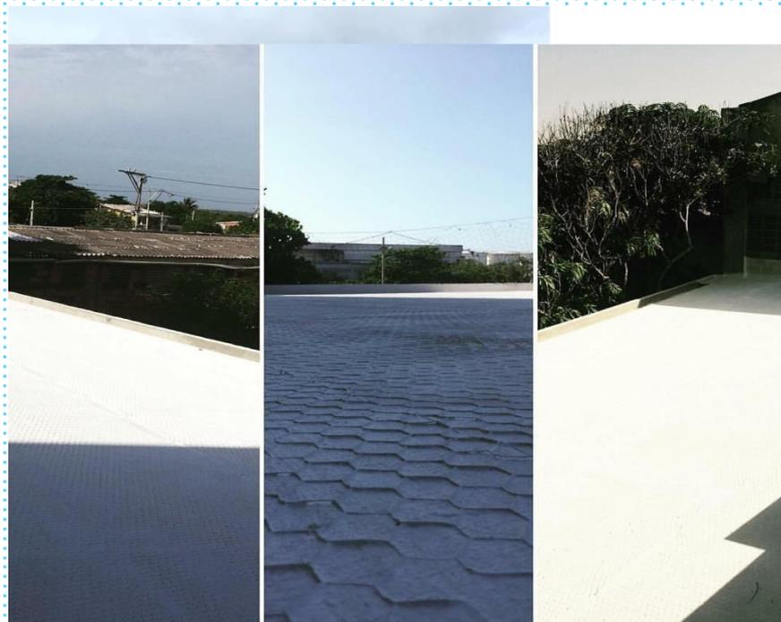
Impermeabilización de la fábrica casa Schlegel Donado! Refuerzo con malla para una losa en superboard de 16 mm usando GOMORTERO y GOMOLASTIC! Calidad garantizada
