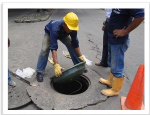
TAPAS DE ALCANTARILLADO
