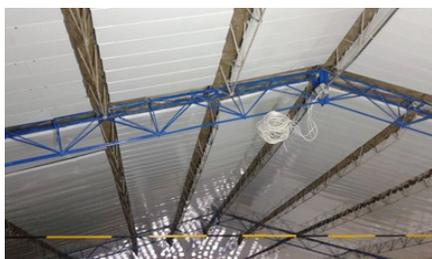
Barreras metálicas de autoensamble que en combinación con mantas de aislamiento mejoran las condiciones térmicas ambientales al interior de áreas de producción y almacenamiento, en plantas y bodegas industriales. Aportan un eficiente aislamiento acústico y gran apariencia estética.
