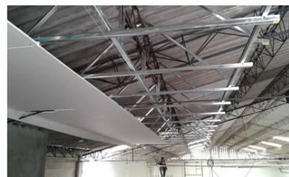
Construcción de cielo rasos y divisiones con placas de yeso y fibrocemento. Sistemas antisísmicos resistentes al fuego que al complementarse con membranas acústicas y fibras minerales, ofrecen alto grado de aislamiento térmico y control de ruido.
