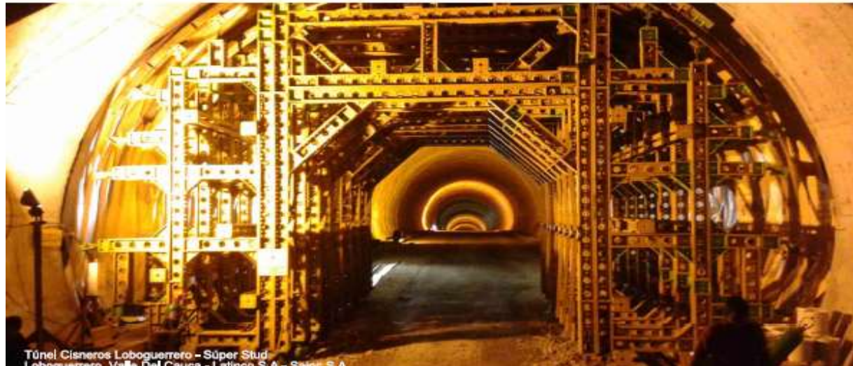
Túnel Cisneros Loboguerrero - Súper Stud Loboguerrero, Valle del Cauca - Lallinco S.A. - Sogamoso S.A.
