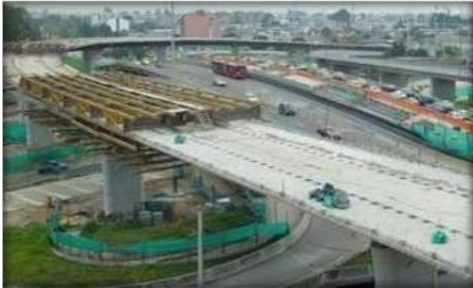
PUENTE CALLE 92 TRANSMILENIO
