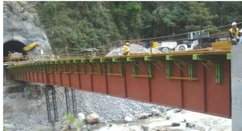
Puente de acceso Casa de Máquinas Hidroeléctrica Amoya Chaparral Tolima – Panel Manual, Super Stud Consorcio Hidroeléctrica Amoya 2006
