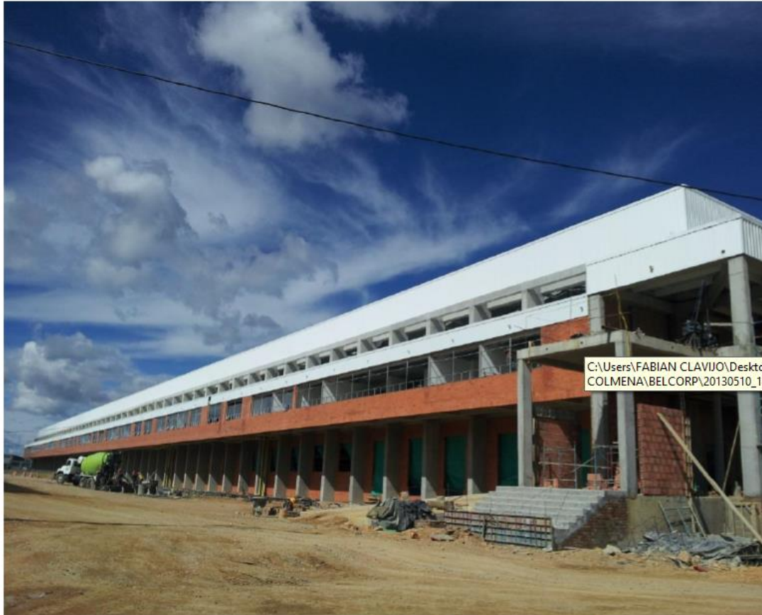
Fabricación e Instalación de Teja metálica para Fachadas en Bodegas Industriales.
