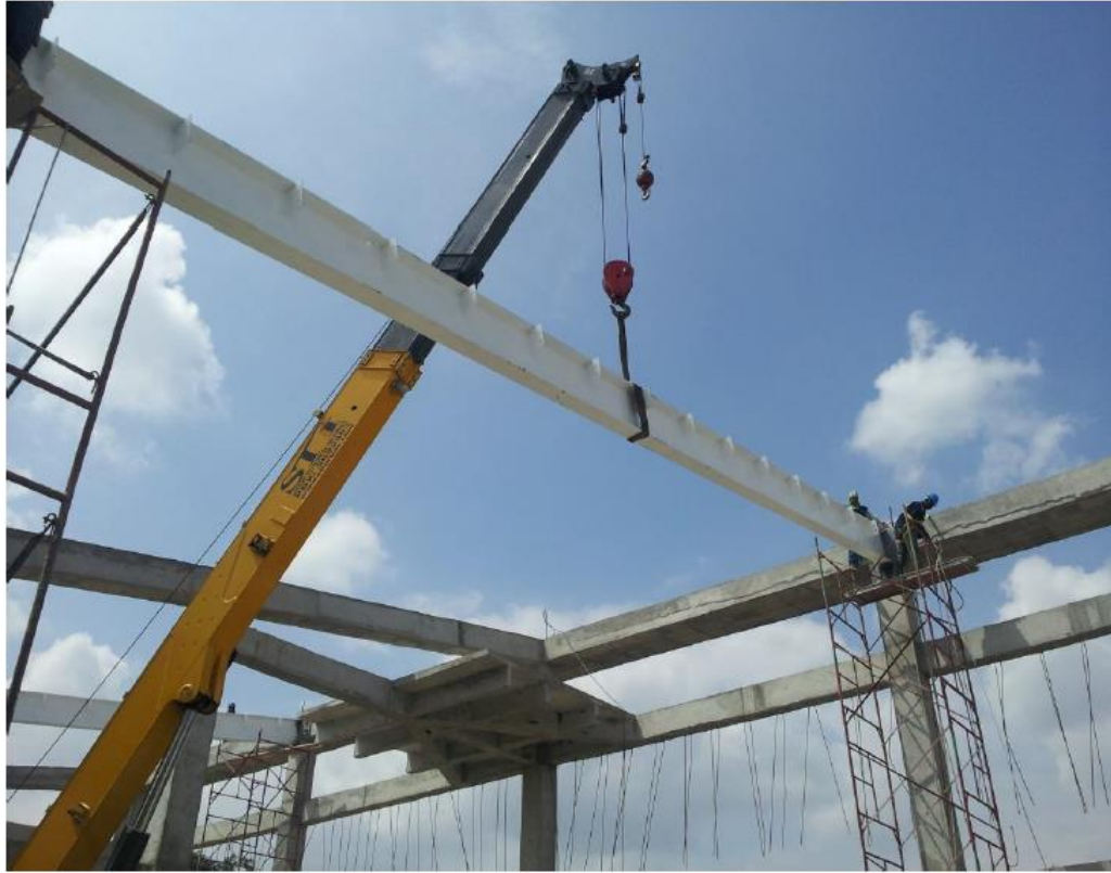
Fabricación y Montaje de Estructura metálica para cubiertas en perfiles de alma llena.
