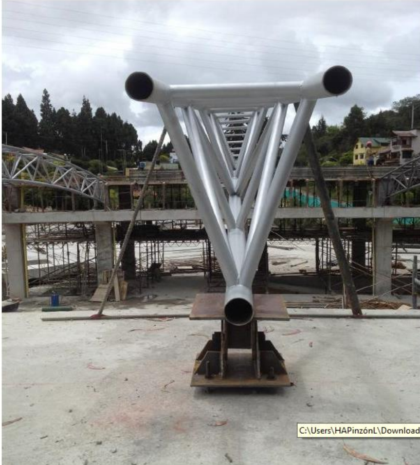
Estructuras de Cubierta en Acero, tipo celosía.
