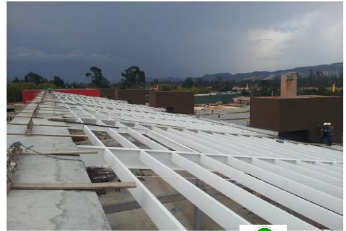
Fabricación y Montaje de Estructura metálica para cubiertas en perfiles de alma llena.
