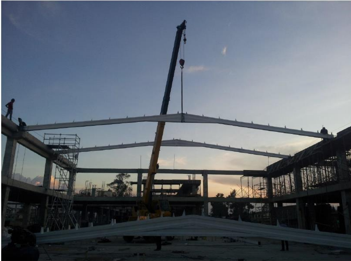
Fabricación y Montaje de Estructura metálica para cubiertas en centros comerciales.
