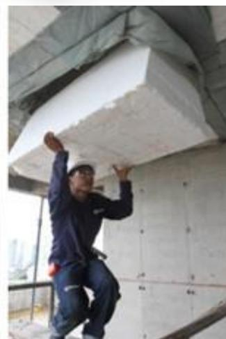
Este producto es una herramienta de construcción versátil que reemplaza cualquier tipo de aligeramiento de losas convencional. Este es un sistema de instalación y recuperación de bloques segmentados de poliestireno expandido (EPS) ignífugo y auto-extingible, recubierto por polietileno, lo que permite una reutilización permanente del producto.
