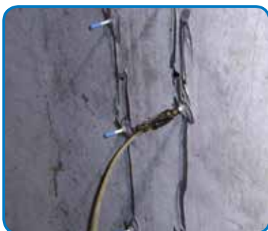
Epoxis de reparación
