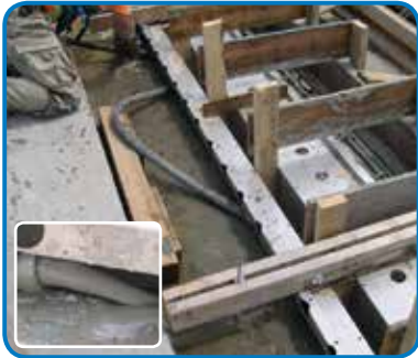
Lechada de construcción
