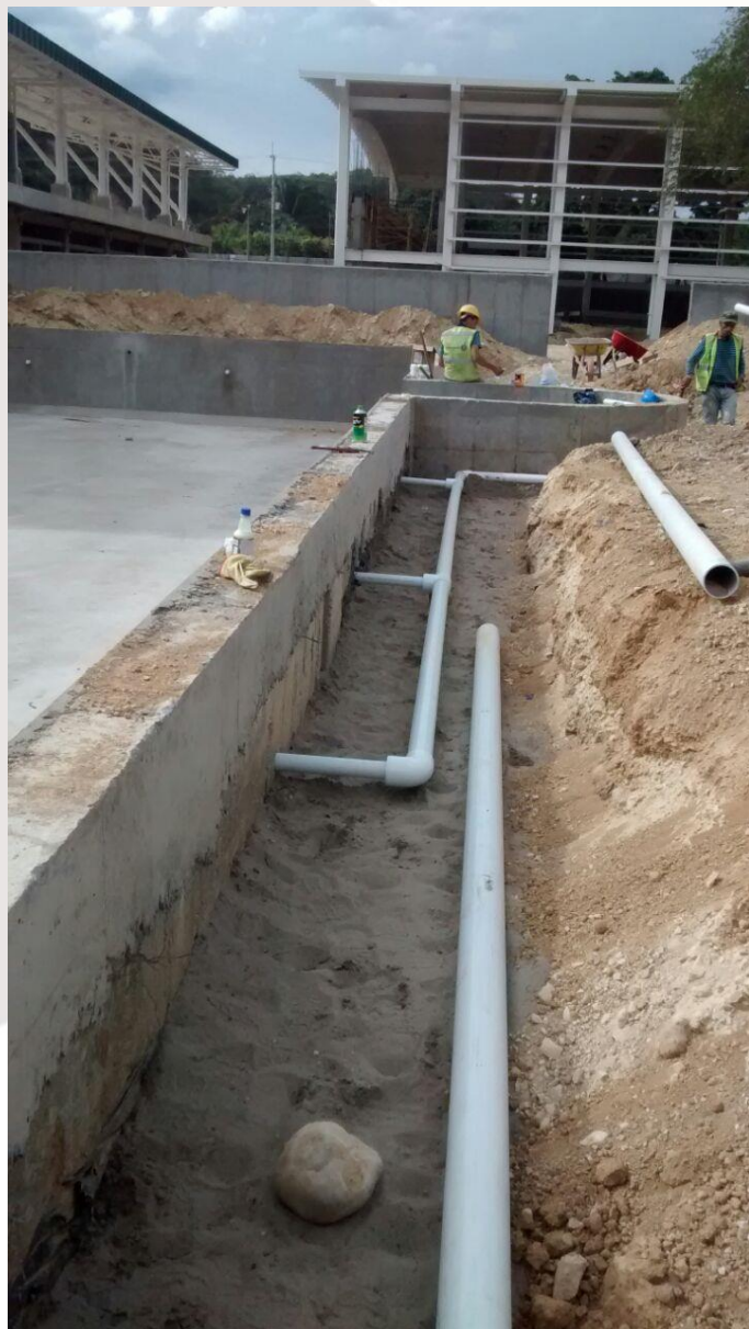
Montaje de redes hidráulicas
