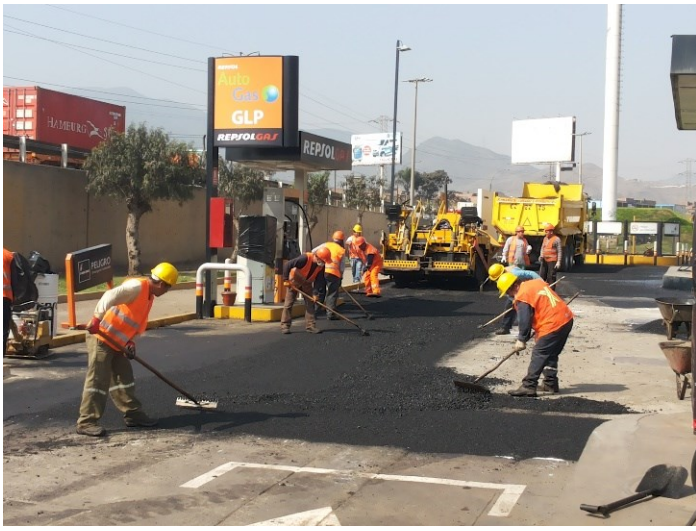
Asfaltado Grifo Repsol: Av. Evitamiento - Riva Agüero (Puente Nuevo) - Feb. 2016
