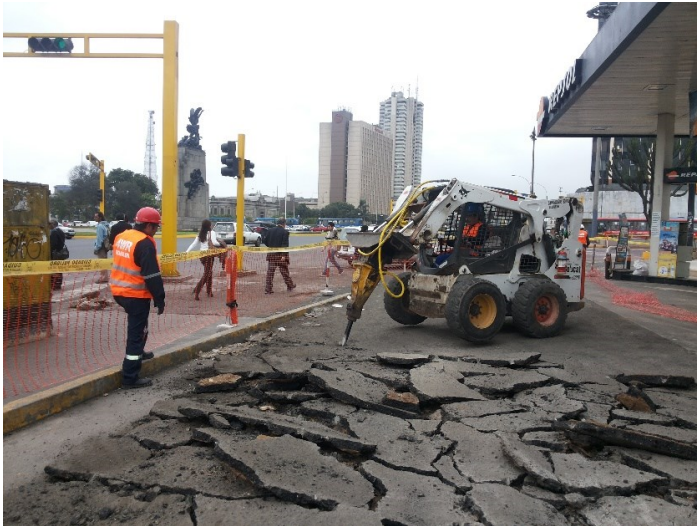
Reparación de Carpeta Asfáltica, Afirmado y Demoliciones Esq. Paseo de la República y Av. Grau - Mayo 2016
