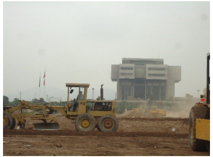
Excavaciones y Movimiento Tierras Masivo (Pentagonito San Borja) - Marzo. 2016
