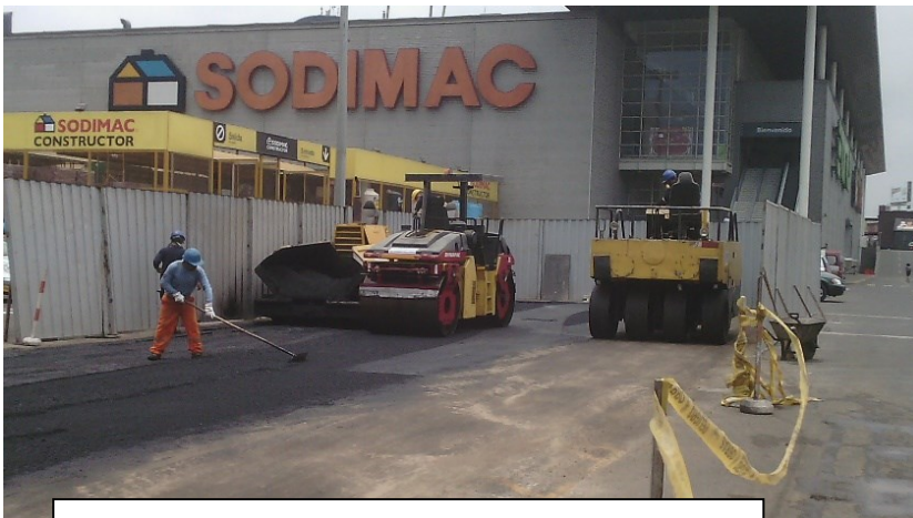
Asfaltado Estacionamiento OPEN LA MARINA TOTUUS / SODIMAC - Nov. 2016
