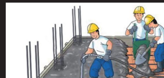
Vaciar el concreto con las maneras tradicionales (bomba, carretilla o directamente) y disperse.
