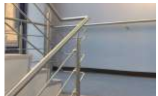
Barandas en Acero
