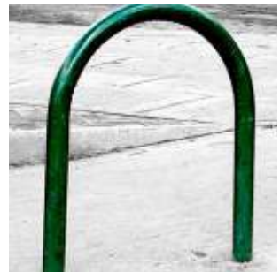
Separador de Cicloruta
